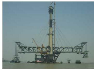
图 4 整节段钢桁梁架设
