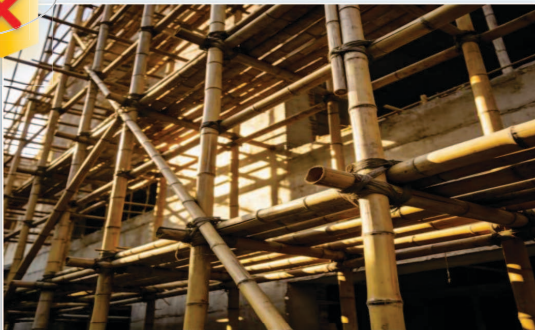
违规使用竹子、木材搭设的脚手架
