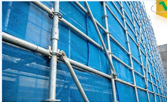
使用阻燃型密目式安全网、冲孔钢板网等
