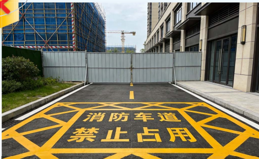
围挡违规占用疏散通道、安全出口、消防车通道
