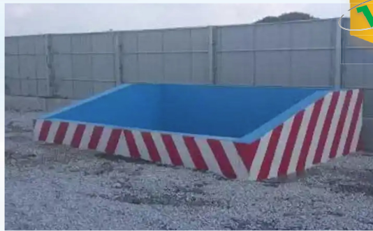
施工现场合理设置建筑垃圾池
