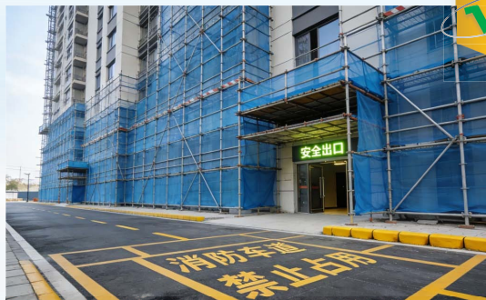
外脚手架未占用疏散通道、安全出口、消防车道
