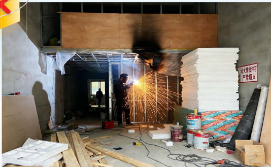
动火作业区域未采取警戒带隔离，设置防火分隔
