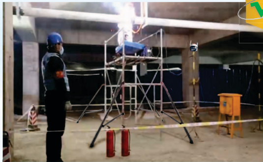
动火作业划定安全区域、设置消防设施及监护人
