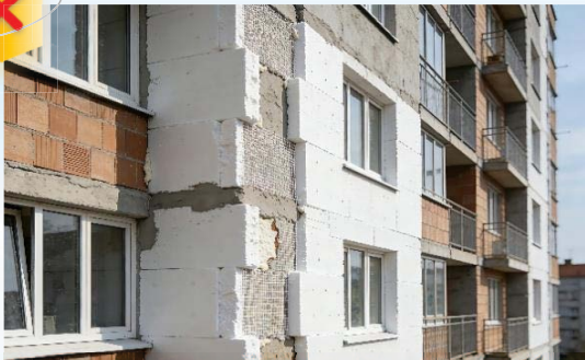
不符合防火等级的材料（B2级：聚苯乙烯保温板）
