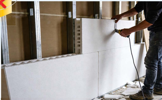
违规使用聚苯乙烯保温材料
