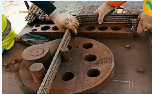
使用“冷弯工艺（一次弯折到位）”
