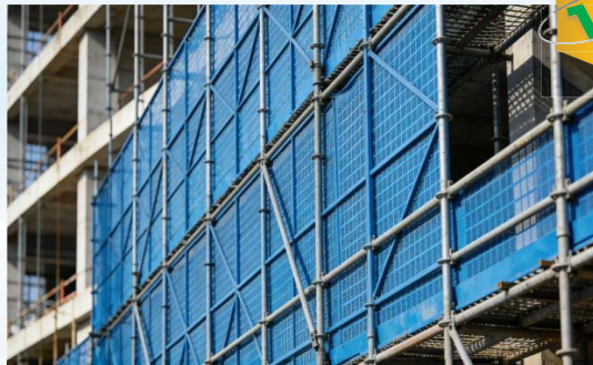
使用阻燃型密目式安全网、冲孔钢板网
