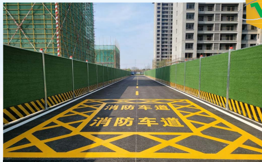
围挡未占用疏散通道、安全出口、消防车通道
