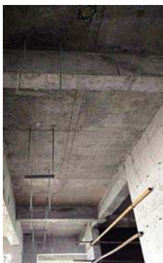
图7 支吊架安装完成 效果图
