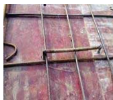
图5 预埋门型架布设
