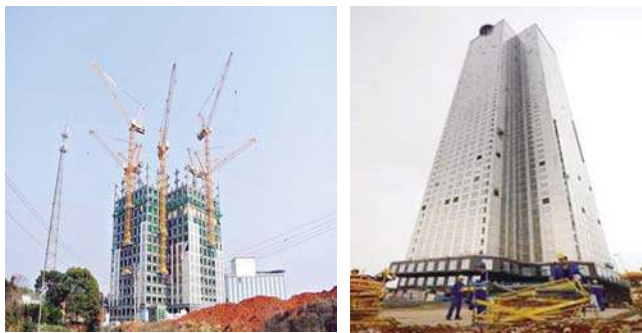
长沙远大可建建造的钢结构“小天地” ——19 天一成 57 个结构层
