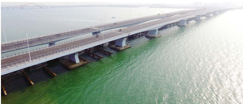
近日,中建三局承建的首座海上大桥——唐山曹妃甸纳潮河中山大桥通车。该大桥全长2380米,双向6车道。(程超 张均)
