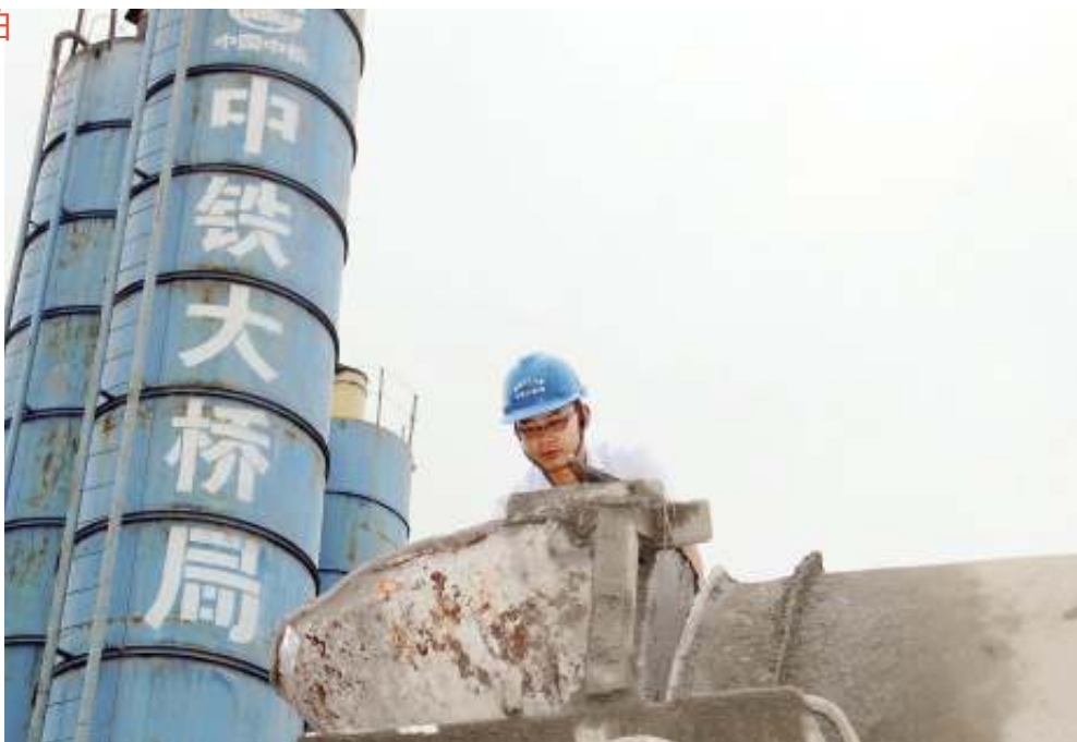
2010年6月,藕长洪在鄂东长江大桥工作期间,图中他爬上罐车尾部,从料斗口查看混凝土工作性。
