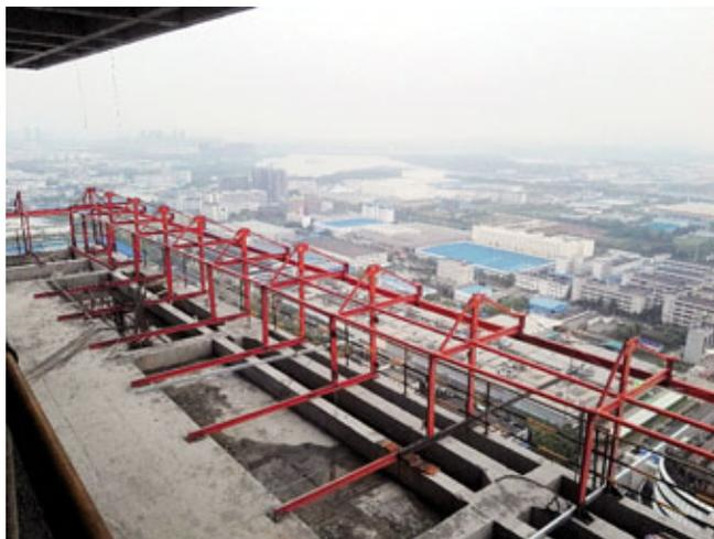
单元式幕墙屋顶单轨吊装系统
