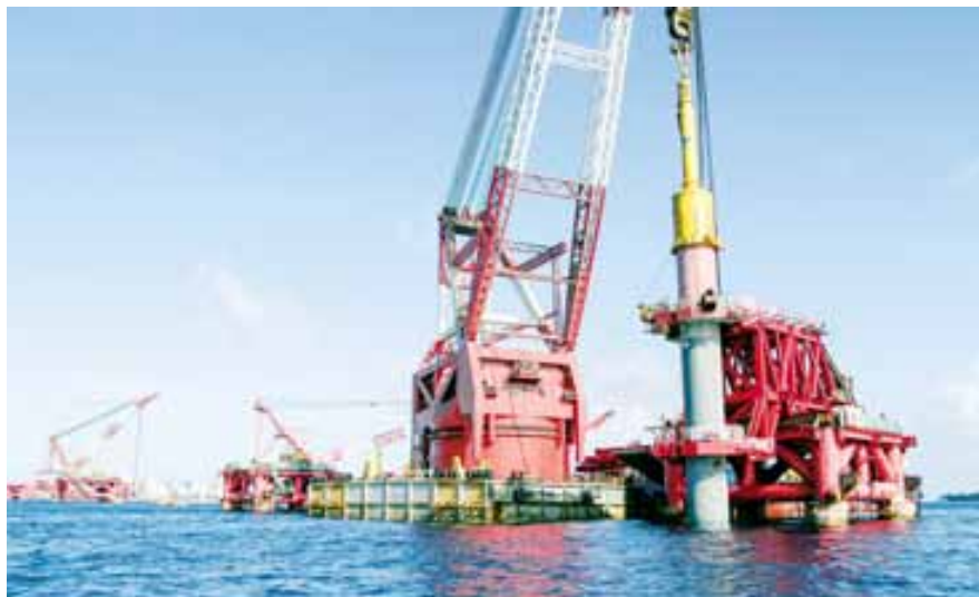
2016.6.12 中马友谊大桥首根桩基钢护筒施沉
