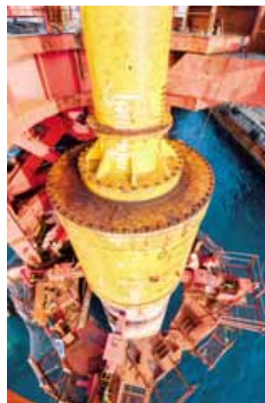
2016.12.3 主桥 20 号墩倒数第二个钢护筒施沉完成(全桥第 34 根)
