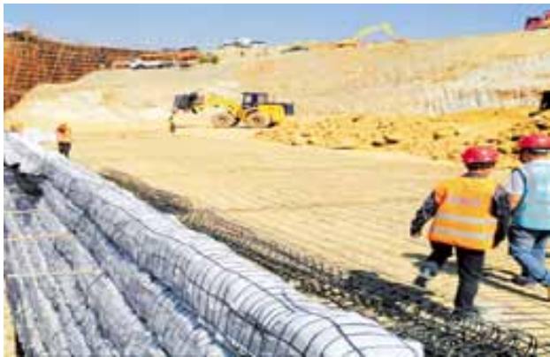
施工措施:临时施工道路
