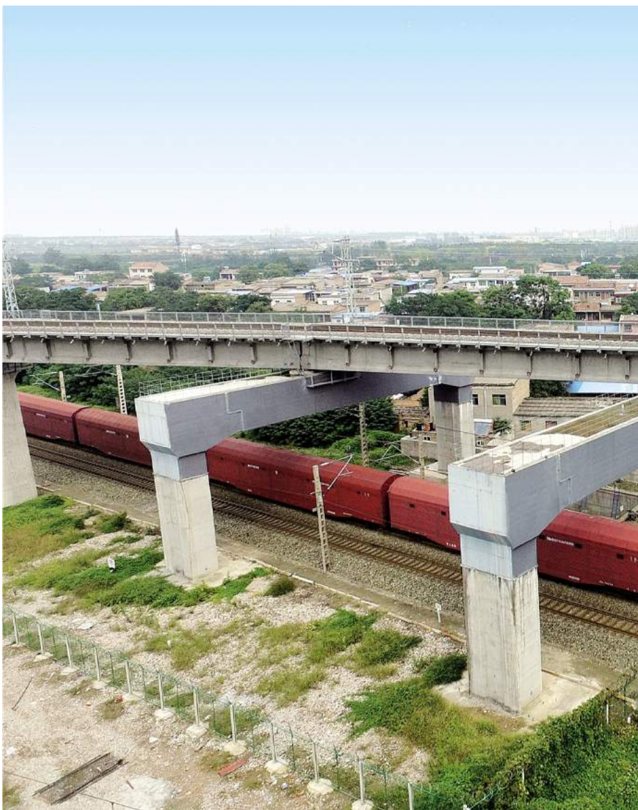
陇海线机车穿越项目部联络线特大桥门式墩
