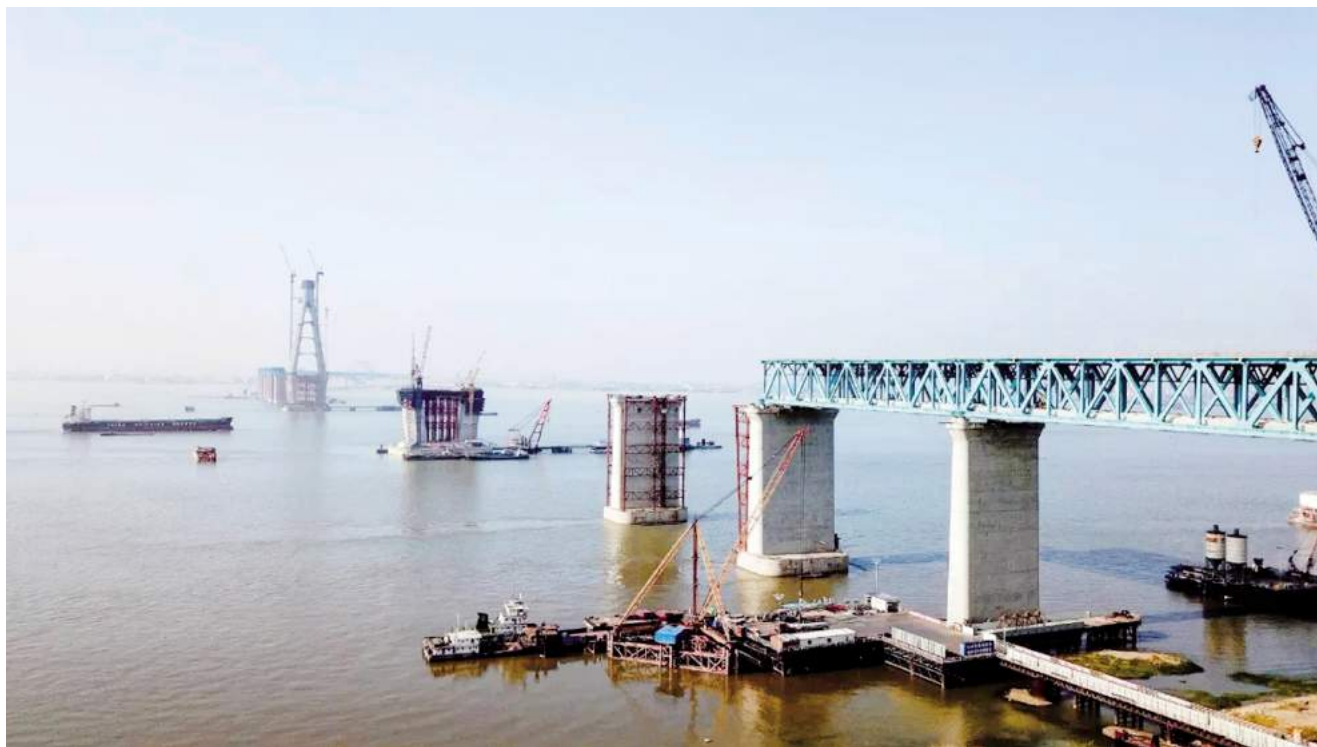
正在建设的沪通长江大桥,是世界上首座跨度超千米的公铁两用斜拉桥。
