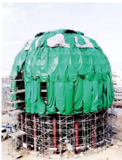
酷暑下安装第二台球上温带板
