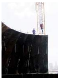
酷暑下安装第二台球上温带板
