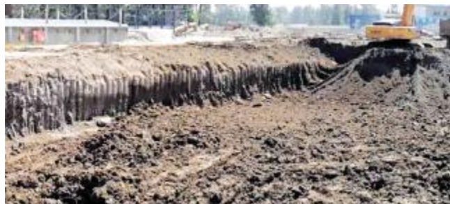
图 5 粉喷桩内插型钢现场照片 1
