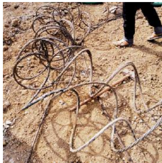
图 6: 回收拔出的钢绞线
