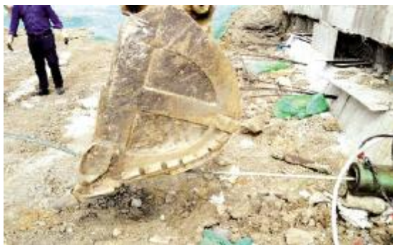
图 5: 用挖掘机拔出钢绞线
