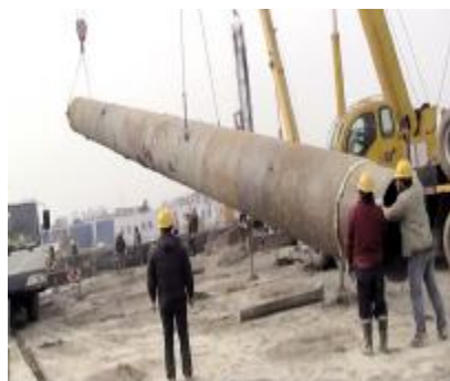
图 3.4.2: 双套管吊装实景图
