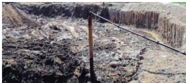
图 6 粉喷桩内插型钢现场照片 2
