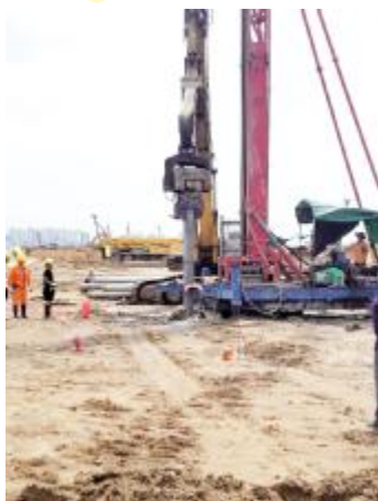
多向加芯搅拌桩现场施工图
