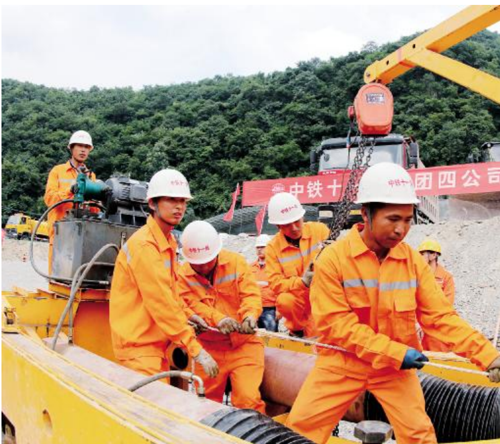
举行隧道塌方应急演练时,救援队员通过应急救援顶管设备往外清理塌方。(宋东升摄)
