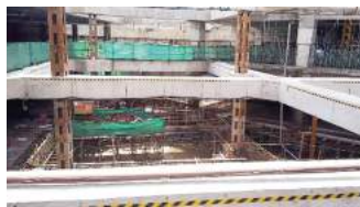
地下室逆作模型与现场施工
