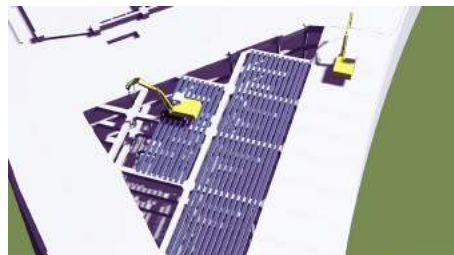
拆除支撑可视化交底
