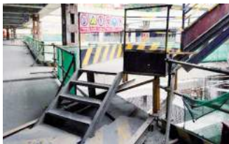
地下室逆作临时爬梯模拟与现场施工
