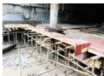
钢管柱环梁可视化交底
