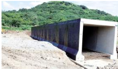
“装配式”小型构造物施工过程图
