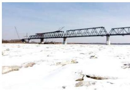
中俄首座跨界河铁路大桥全线贯通
