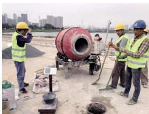
透水混凝土现场拌制
