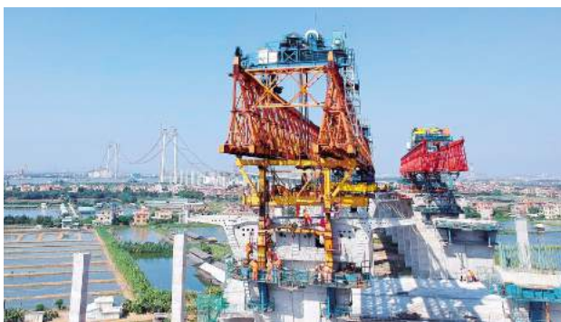
2017年7月20日,虎门二桥架桥机施工作业场景。王滔摄
