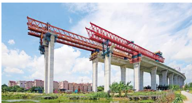
2017年6月8日,南沙大桥架桥机拼装施工场景。王滔摄
