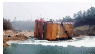
7#墩钢套箱围堰下水
