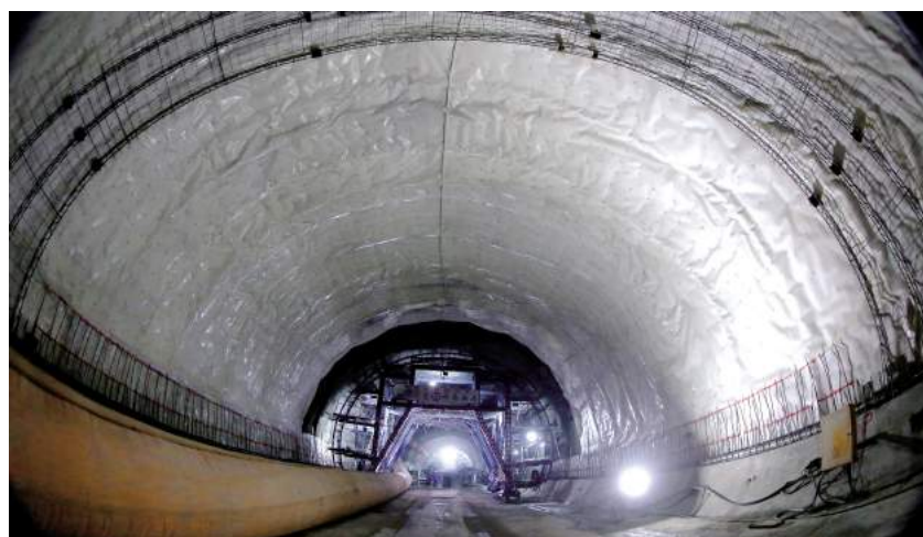
都安隧道出口,刚刚敷设好的二衬防水板,如同工艺品一般。
