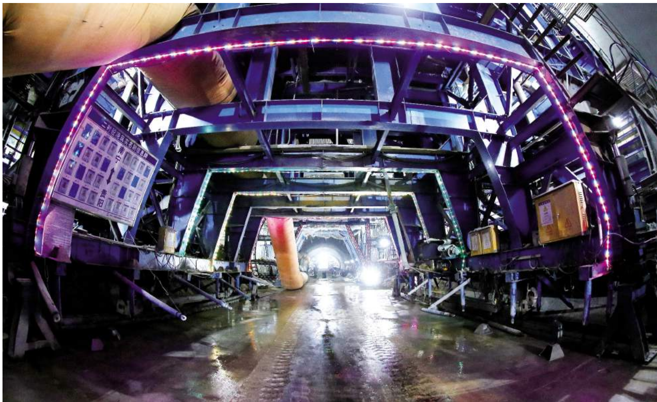
都安隧道出口，“光伟”系统运用到二衬混凝土施工后，从根本上杜绝了二衬空洞现象。
