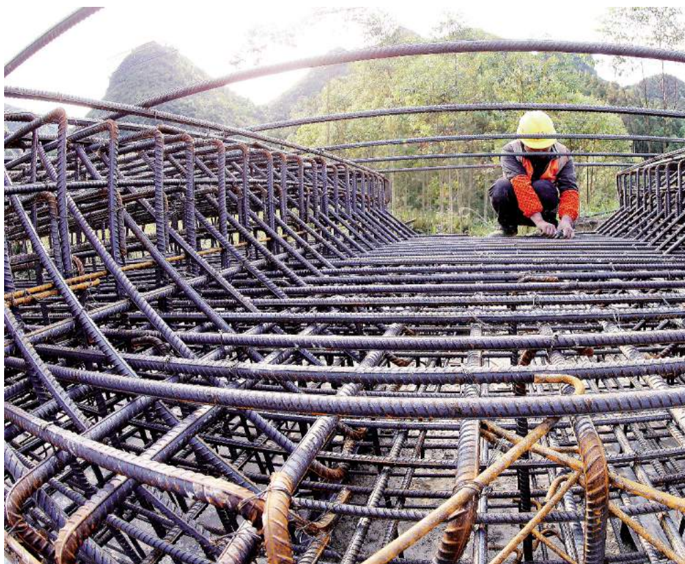
工人在香福双线特大桥绑扎桥墩墩帽钢筋。
