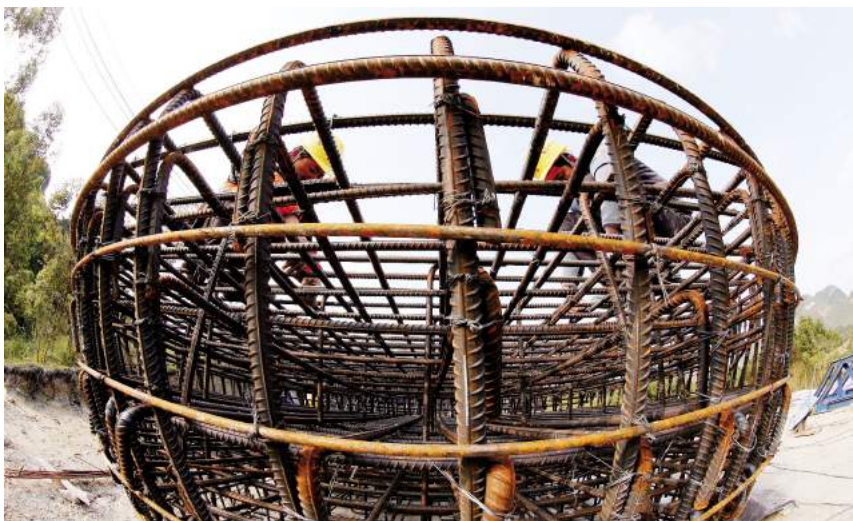
工人在香福双线特大桥工地检查桥墩墩帽钢筋绑扎质量。
