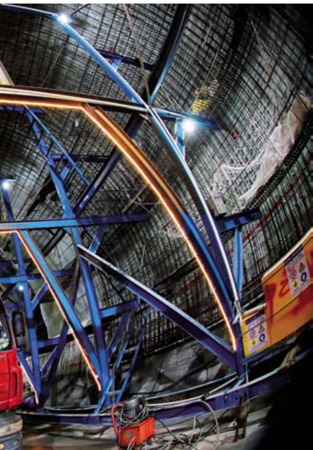
都安隧道明洞的二衬钢筋网下面,运送防水材料的大货车正在卸载物资。
