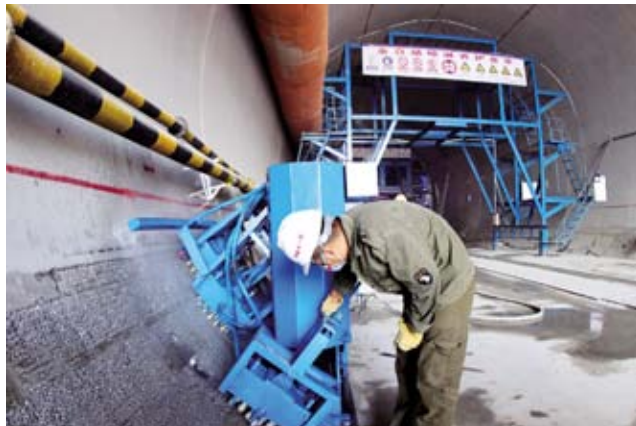
工人在都安隧道出口左则边墙,用自主研发的多功能凿毛机,在水沟电缆槽凿毛。
