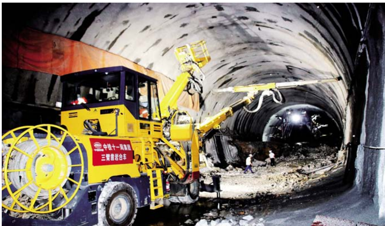
中铁十一局贵南高铁广西段都安隧道出口，全智能三臂凿岩台车正在作业。
