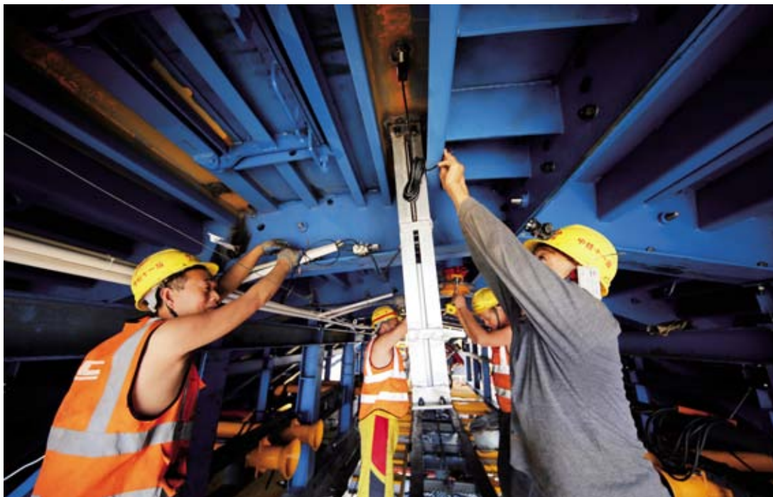
5月24日，技术人员第二次对“光伟”二衬智能台车电路系统和拱顶混凝土植入系统进行升级改造。
