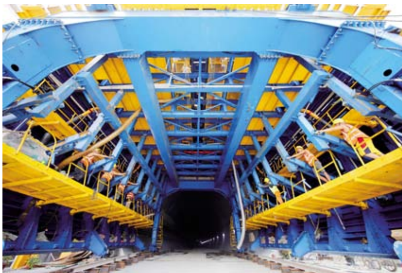
5月24日,贵南高铁都安隧道出口,工人在检查升级后的“光伟”二衬智能台车支撑系统加固情况。
