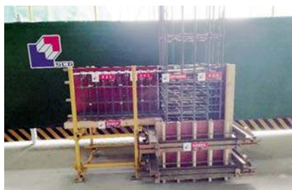
梁柱节点样板引路
