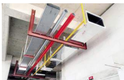
通风消防管道及桥架风管样板引路
