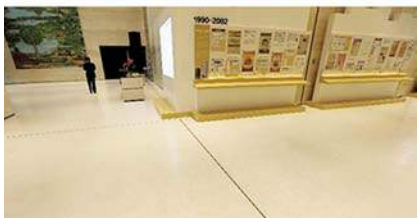
PANDOMO 整体式地坪质地坚固，色泽亮丽，表面光洁无裂纹，铜条镶嵌工艺精致
