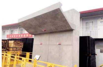
清水混凝土墙及挑檐样板引路
