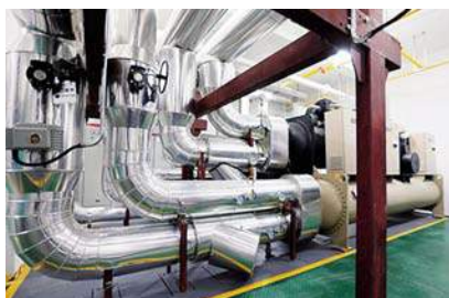
变频磁悬浮预制式集成冷冻站系统安装规范，管道分层合理，设备运行稳定高效，节能静音
