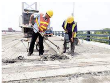
烈日下,施工人员桥头摊铺接平中
