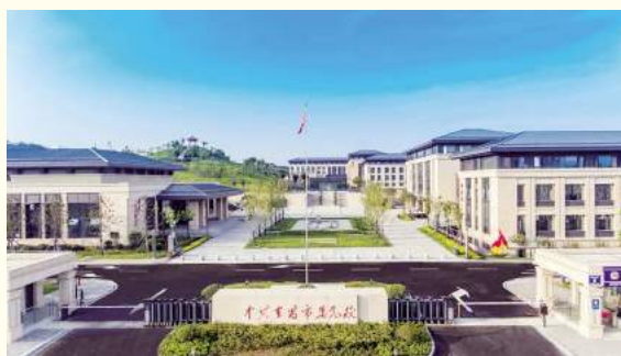
广盛公司首个鲁班奖工程——宜昌市委党校
