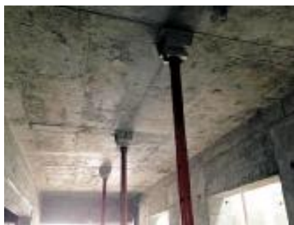
快装早拆的铝合金模架系统已经在深圳普及
