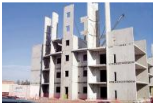
把三层剪力墙做成一块可以大大降低构件和 施工成本
