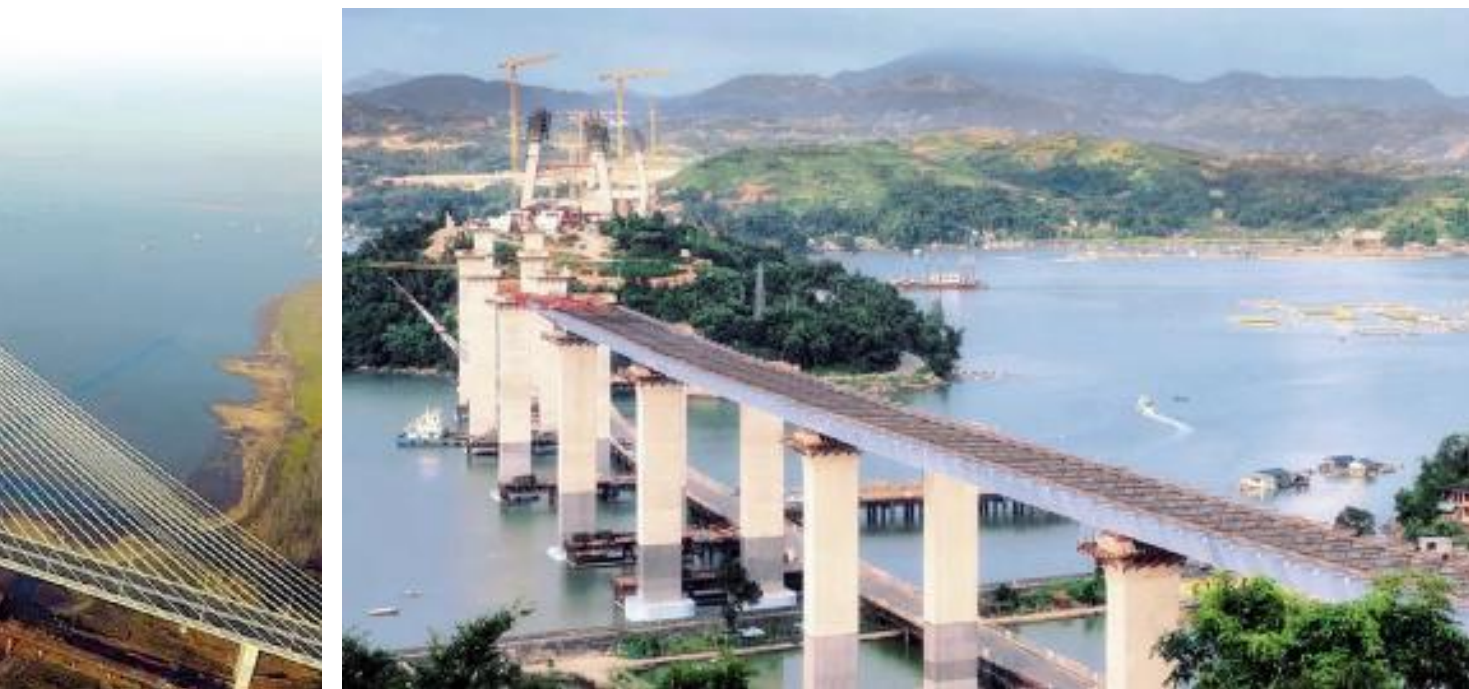
沙埕湾跨海大桥南引桥顶推施工现场
