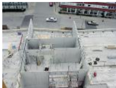
双面预制叠合式剪力墙是先进的免模板技术
