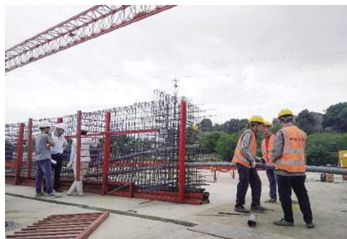
图 9 预应力波纹管安装
