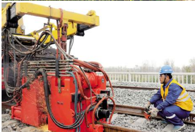
长轨焊接施工
