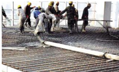
浇筑作业施工
