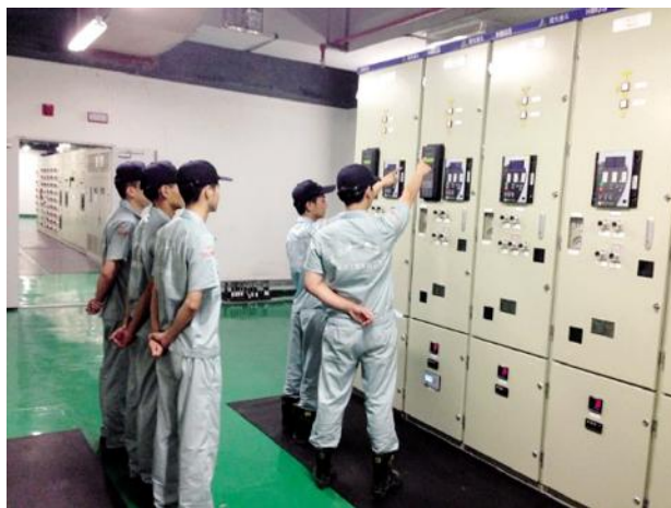
上海地铁 - 35KV 高压开关柜检测
