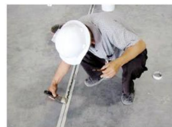
手工填缝
