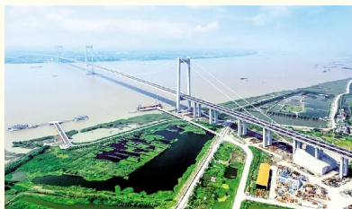
泰州长江公路大桥
