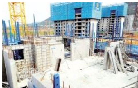
图 12 预制剪力墙深化及安装
