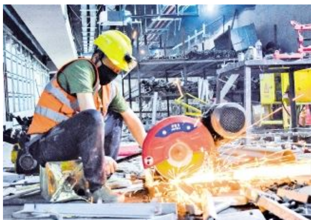
成都地铁6号线三期项目现场工人加工角钢
