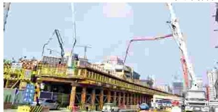
箱梁混凝土浇筑
