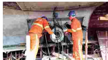
混凝土箱梁张拉
