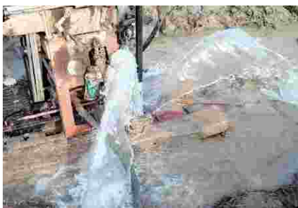
图7 钻孔中的岩溶裂隙水喷出地表
