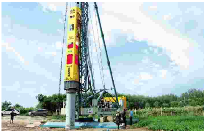
图9 西安外环高架 \Phi 800 管桩施工
