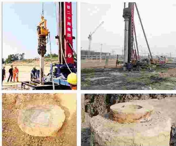
图 5 大直径超深搅拌加芯一体化桩机施工现场
