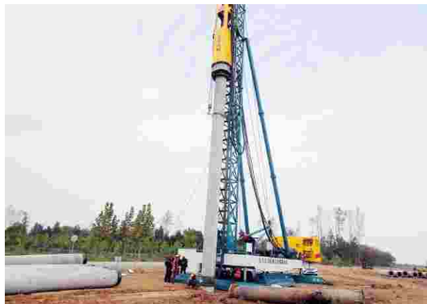
图10 上罗高速淮河特大桥 \Phi 800 施工
