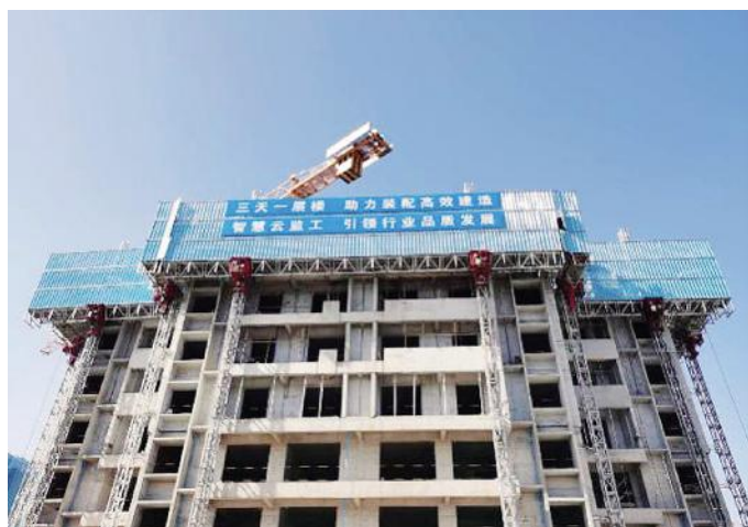
图8 爬升式施工平台现场爬升
