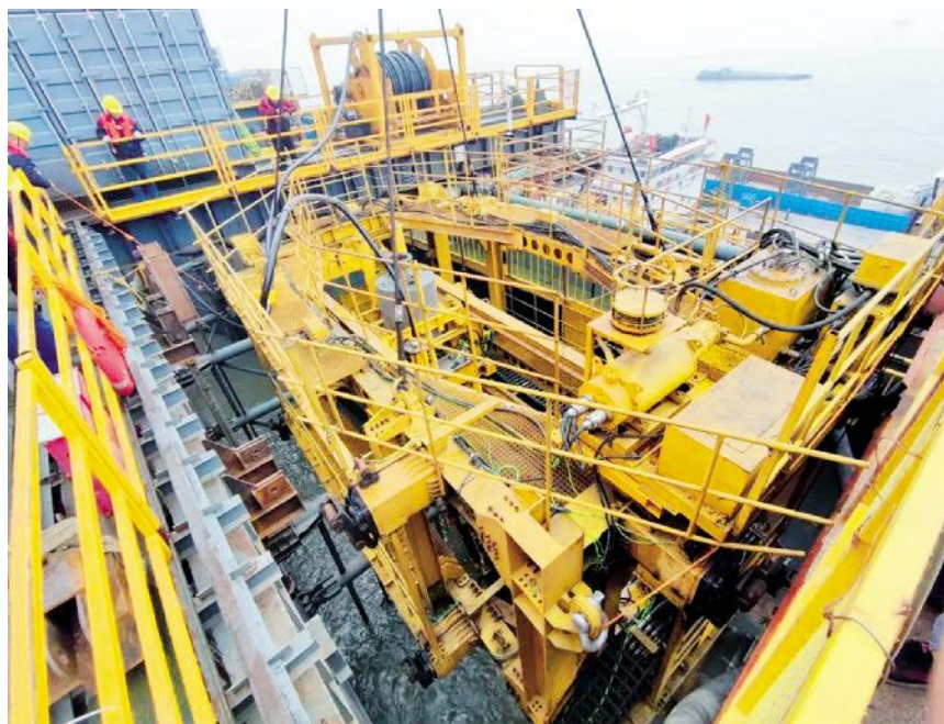
龙门式绞吸机器人下水并进行水下取土作业
