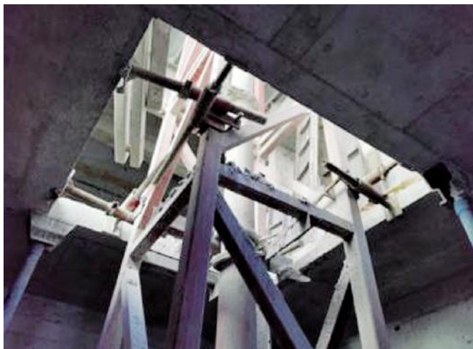
图 12 内爬支撑装置加固
