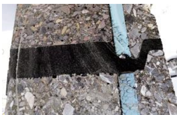
图十 三明治墙体连通腔垂直剖切图
