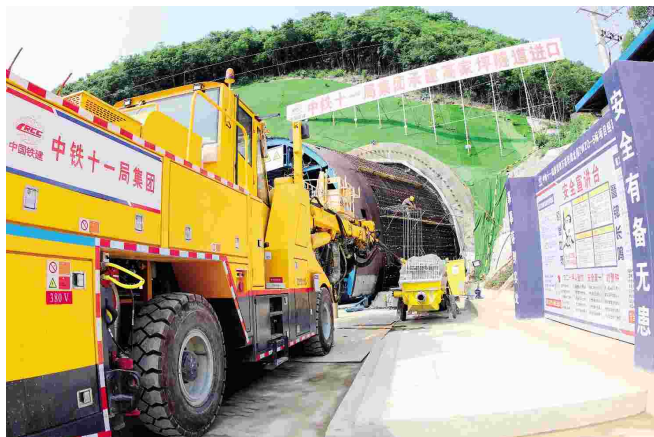
2017 年 6 月 16 日,中铁十一局四公司郑万高铁高家坪隧道,全智能三臂凿岩台车准备进洞作业。(郑传海摄)
