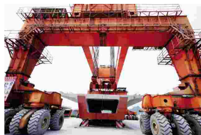
贵南高铁澄江双线特大桥制梁场,提梁机正在吊装重达900吨的箱梁。(郑传海摄)
