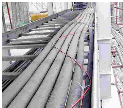
图3 电缆测温光纤敷设示意图
