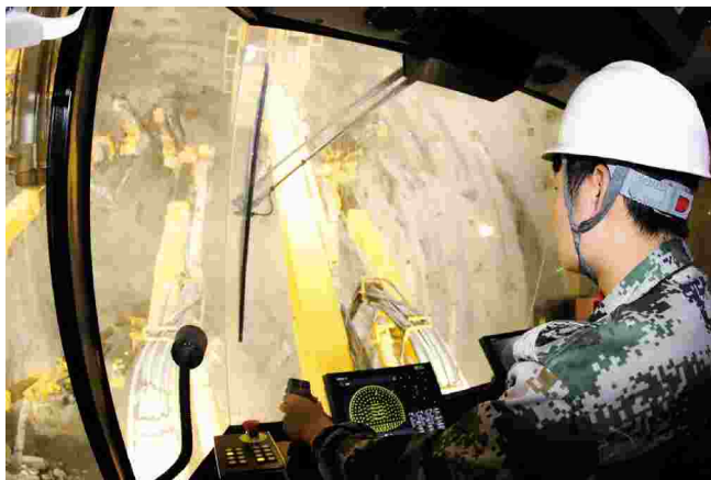
2017 年 6 月 16 日,中铁十一局四公司智能凿岩台车操作手在郑万高铁高家坪隧道掘进作业。(郑传海摄)
