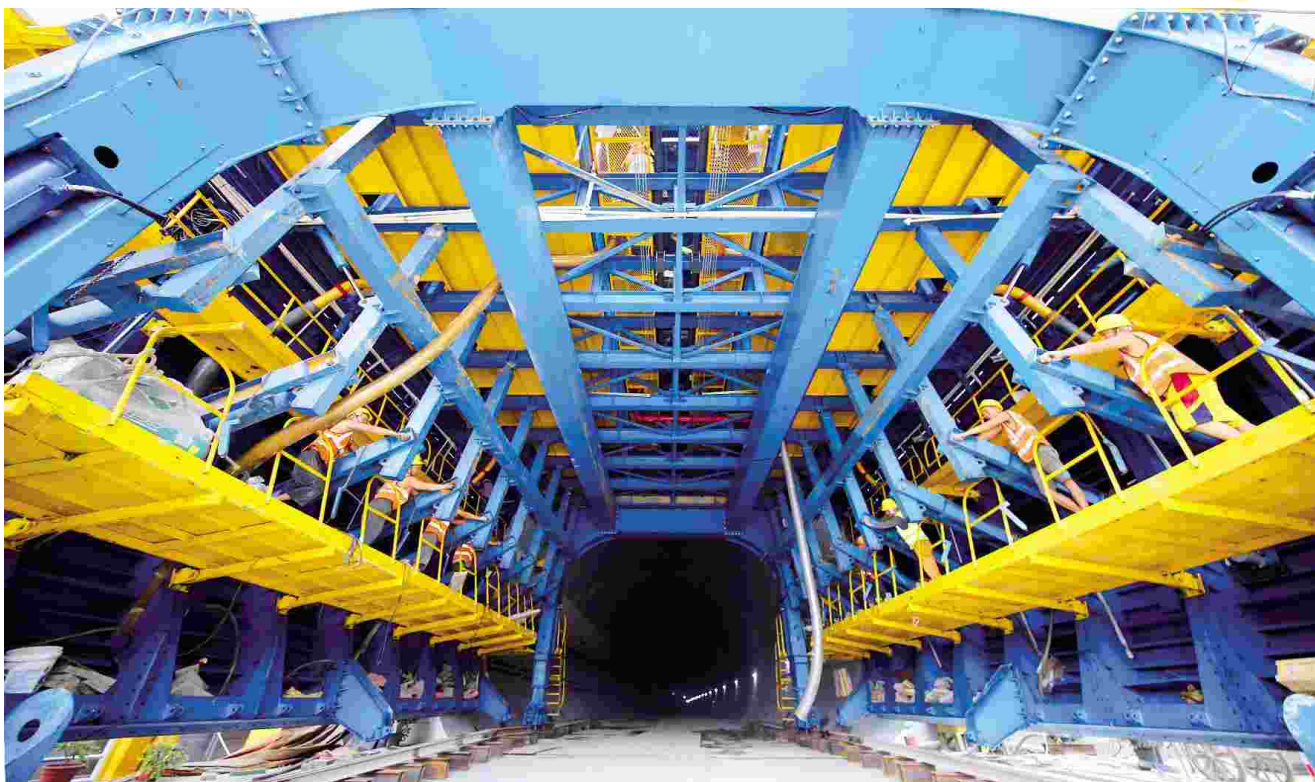
2019年5月24日,贵南高铁都安隧道出口,工人在检查升级后的“光伟”二衬智能台车支撑系统加固情况。(郑传海摄)
