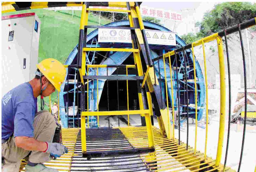
2017 年 6 月 16 日,中铁十一局四公司员工在郑万高铁高家坪隧道进口,安装防水板台车。(郑传海摄)
