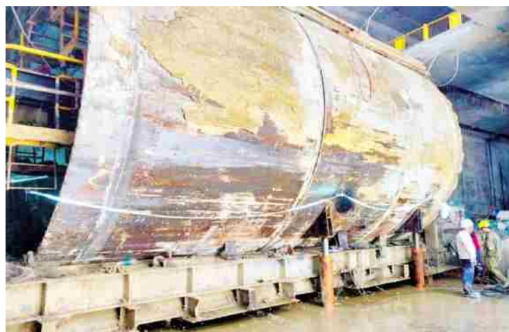
图 3.3-3 盾构机再次侧向平移示意图
