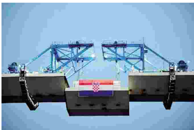
全桥最后一个合龙口正在吊装
