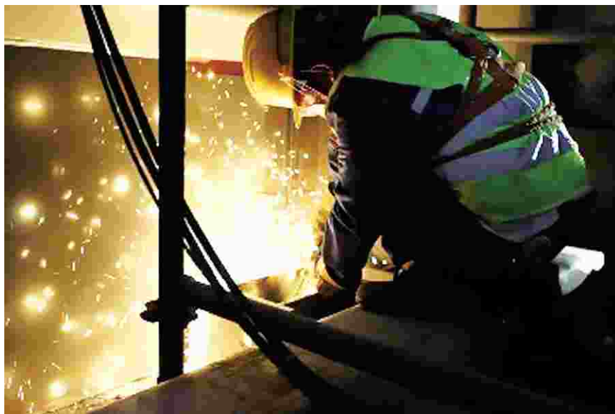
钢箱梁环缝焊接
