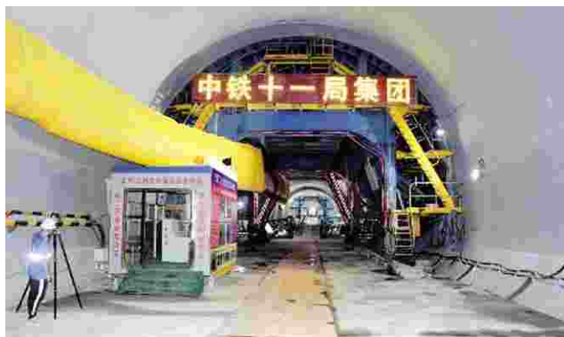
自主研发的二衬智能信息化浇筑系统
