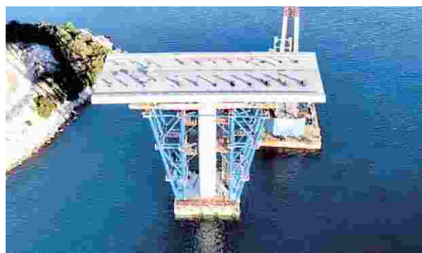
S3 墩顶大节段架设完成
