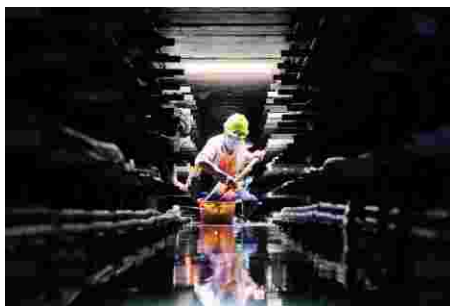
郑州东车辆段电缆廊道清淤抽水
