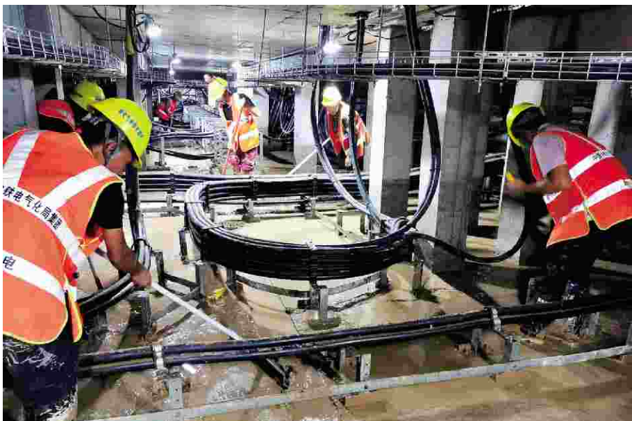
电缆夹层淤泥清理
