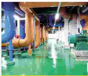
冷冻机房保温管道采用PVC材质，
