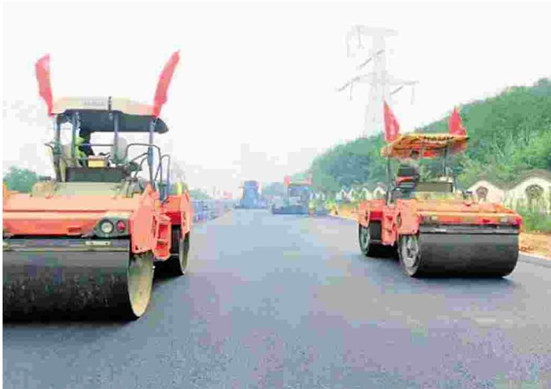
汉川马口项目沥青混凝土下面层试验段摊铺
