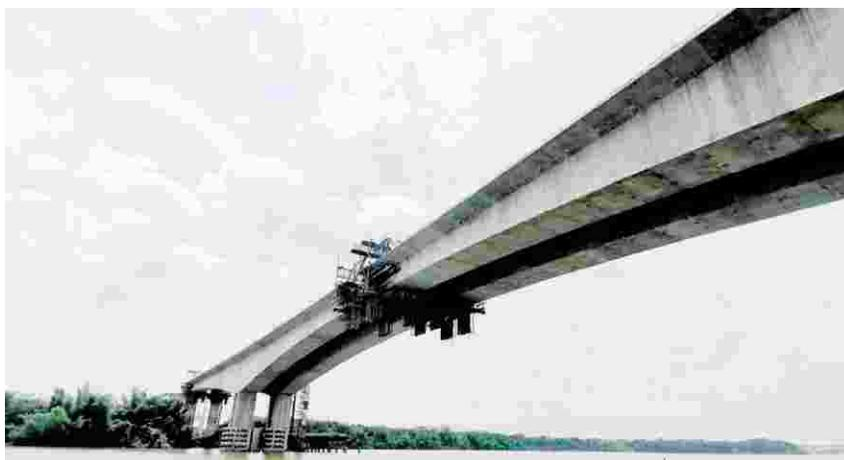
▲2020年6月23日，潮汕环线高速公路全线控制性工程——韩江东大桥主汉桥左幅合龙。
