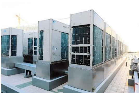
屋面设备布局合理,成排成线,安装稳固,检修便捷,实用美观。
