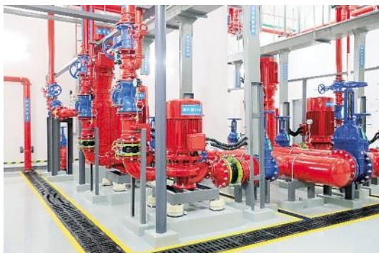
泵房设备排布合理,安装牢固,减震有效,接地可靠,阀门、仪表成排成线,机房排水通畅,导流槽设置合理、顺直美观。
