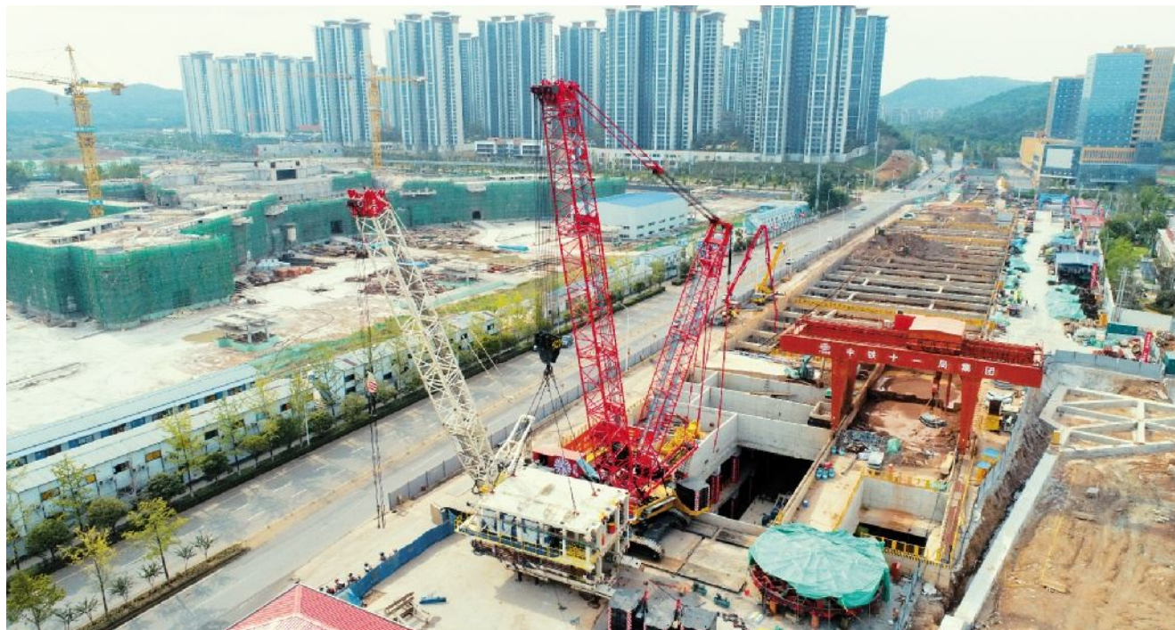
2021年7月31日,由中国铁建总承包的长株潭地铁西环线一期工程2标首台大盾构机掘进施工,在中铁十一局城轨公司2号台车吊装就位。
