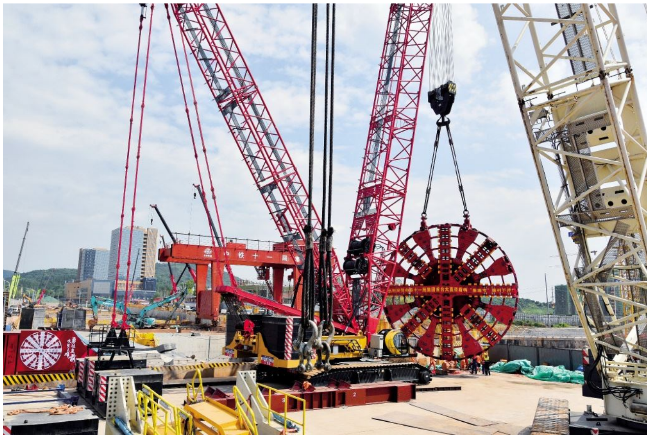
2021年8月20日,中铁十一局城轨公司长株潭地铁西环线一期工程首台大盾构机“星莲”号刀盘开始吊装就位。
