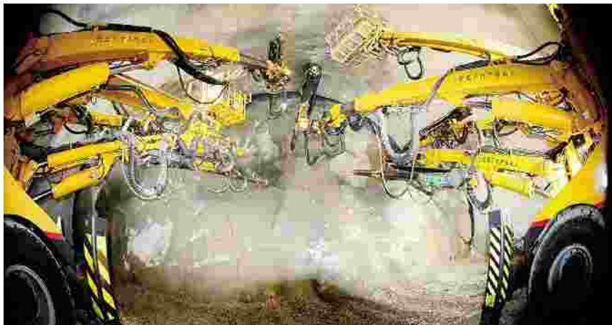
2017年7月16日,中铁十一局四公司郑万高铁高家坪隧道掘进现场,2名机械手操作两台国产全智能三臂凿岩台车在掘进比赛。
