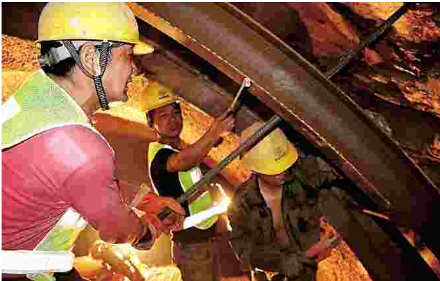
2016年12月21日,中铁十一局玉磨铁路工人在新华隧道2号横洞校正钢拱架
