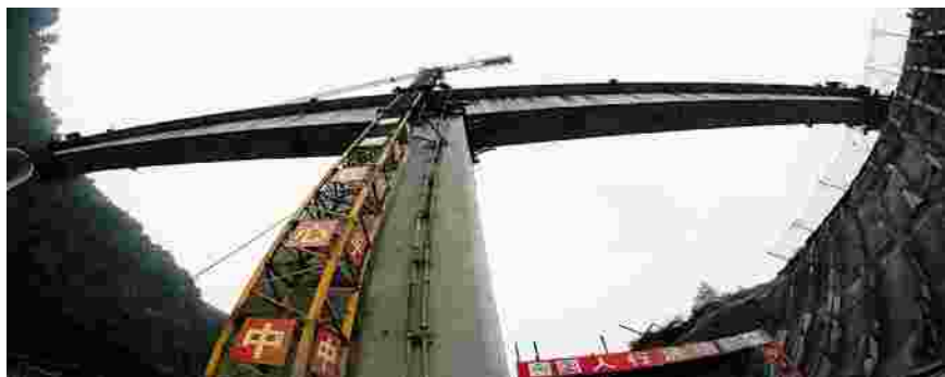
由中铁十一局四公司负责施工的黔张常铁路澧水南源大桥，位于大山深处，设计为薄壁空心墩，墩高49米，施工高度达60米。
