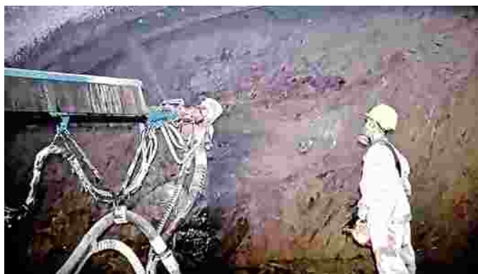
在中老铁路普洱境内的石头寨隧道进口，由念保健带领的劳务队伍操作手通过操作按钮喷射混凝土。
