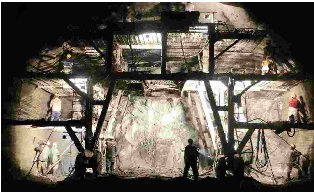
2013年11月5日,在中铁十一局三浙高速公路珠宝沟隧道(河南省卢氏县境内),16名风枪手,手持16把风枪,在隧道掌子面掘进比赛。
