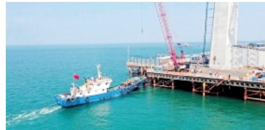
先导索为基础,通过东、西主塔门架平台上的卷扬机,往复牵引不同直径绳索,最后置换成直径36毫米的钢绳。接下来,伶仃洋大桥还要进行主塔与锚碇之间的牵引系统施工,接收到先导索后,将同步开展下游先导索置换施工,计划本月底完成所有牵引系统施工。
