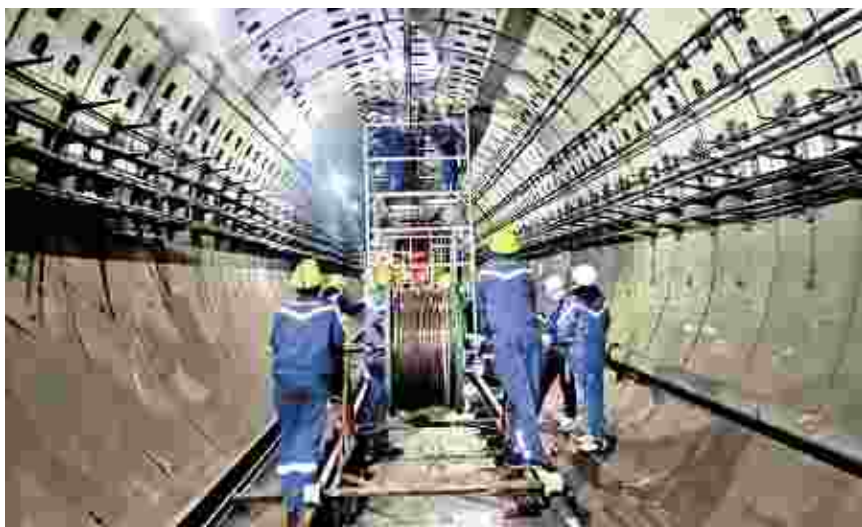
2月3日凌晨,中铁十一局电务公司员工在上海地铁8号线调整更换接触网,保障春节期间上海市民出行便捷与安全。(徐干摄)
