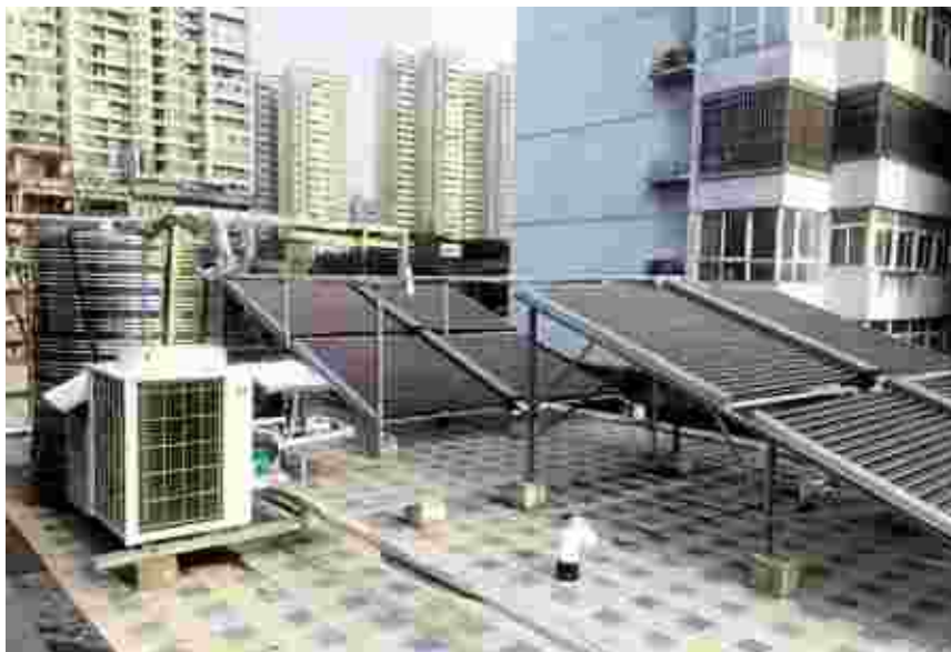
太阳能热水系统屋面装置
