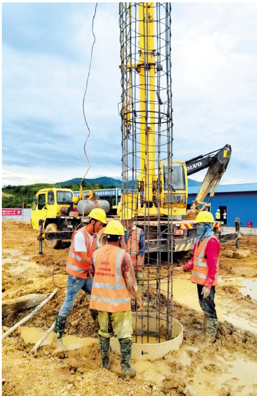
2020年7月6日，雨后刚晴，中国铁建电气化局南方公司磨万铁路项目部员工，抓紧时间在孟赛信号楼工地放置钢筋笼。（廖建文摄）
