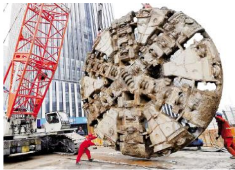
“知音号”盾构机刀盘吊出
