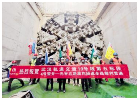
19号线第五标段盾构隧道全部贯通
