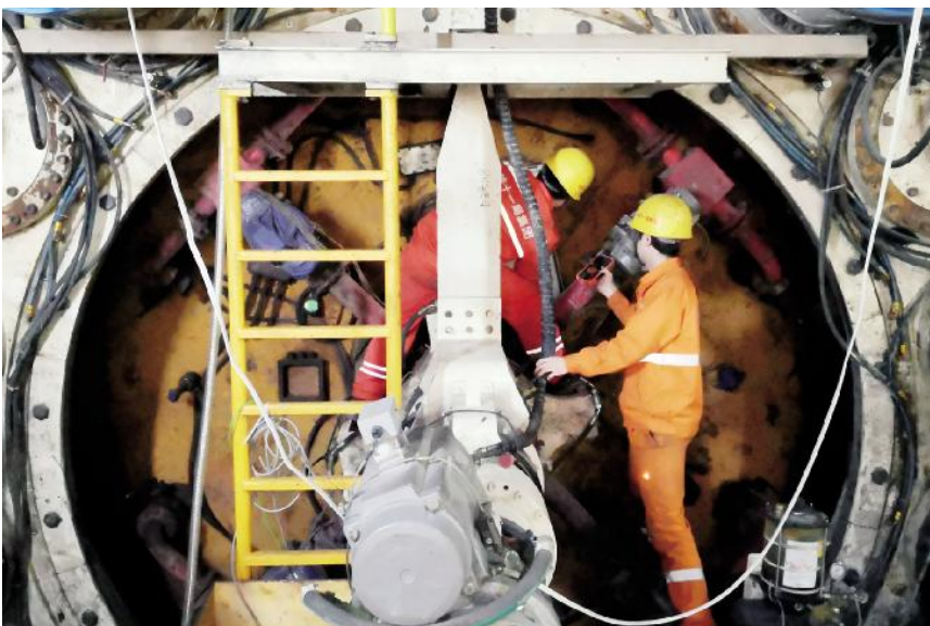
2021年10月17日，中铁十一局城轨公司长株潭地铁项目员工，在长株潭西环线红桥站掌子面安装调整“星莲号”大盾构机。 (郑传海摄)
