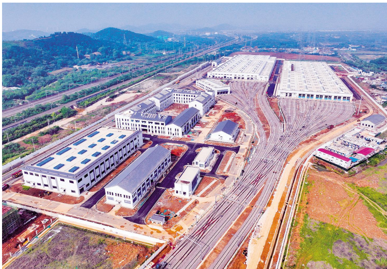
4月20日航拍的武汉地铁19号线花山车辆段基地。该车辆段位于花山大道、武黄城际铁路和武九铁路西北区域。东西长约1330米,南北最宽约390米,占地面积约28公顷。承担19号线部分车辆停放、运用、周月检、定临修、大架修等工作。中铁十一局六公司负责承建。(黄跃勇摄)
