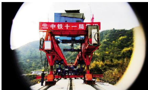
2018年3月22日,中铁十一局四公司架桥机在黔张常铁路蚂蝗冲大桥架梁已经实现过半。(郑传海摄)
