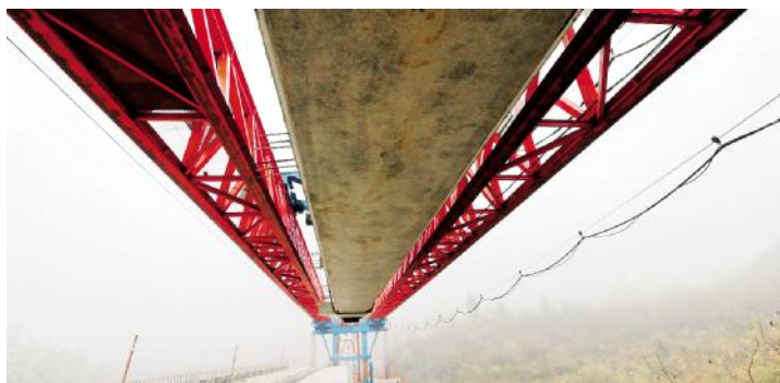
2018年3月22日,中铁十一局四公司架桥机穿过薄雾,提着预制梁慢慢地往桥墩上降落。(郑传海摄)
