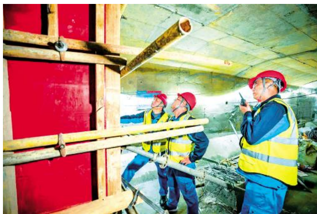
项目管理人员正在桥梁箱梁内检查混凝土浇筑情况
