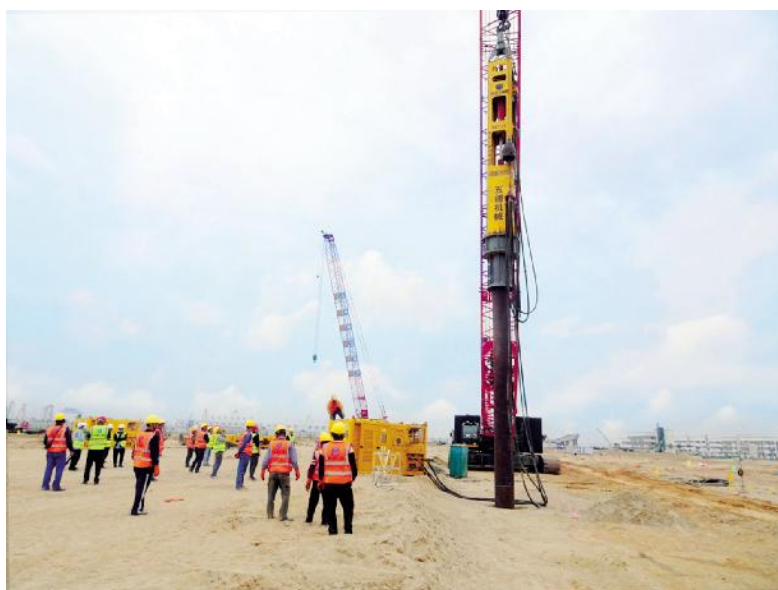
图1 预制管桩锤击吊打法施工场景
