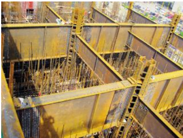
型钢梁柱安装
