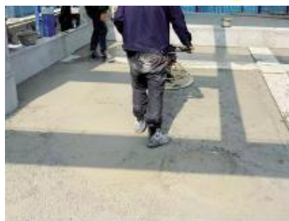
细石混凝土浇筑收面图
