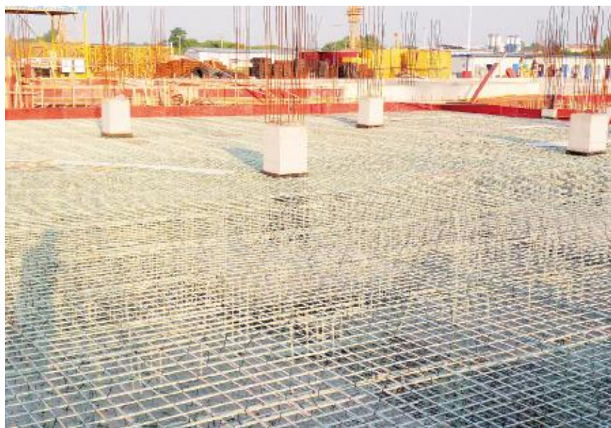
设备基础玻璃纤维筋安装完成效果
