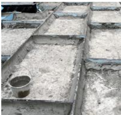
分隔缝嵌塑料线条设置图
