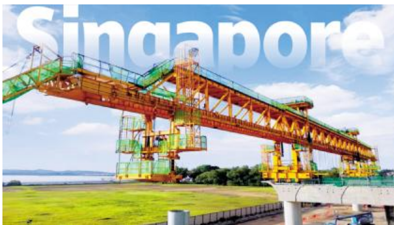
480吨节段拼装架桥机在新加坡投入使用
