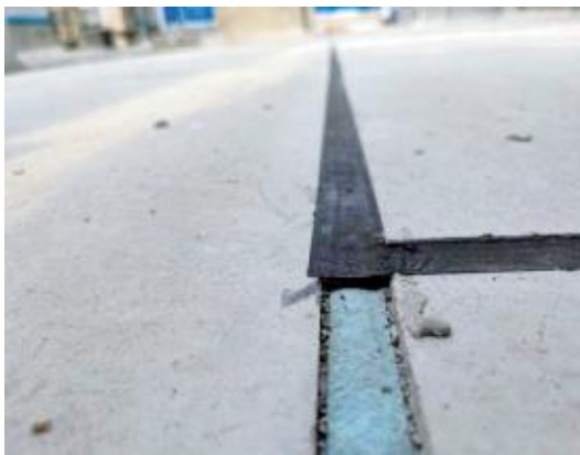
分隔缝清缝、嵌缝图
