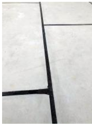
分隔缝清缝、嵌缝图
