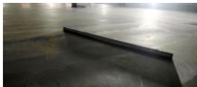
大面积的超平混凝土地坪验收
