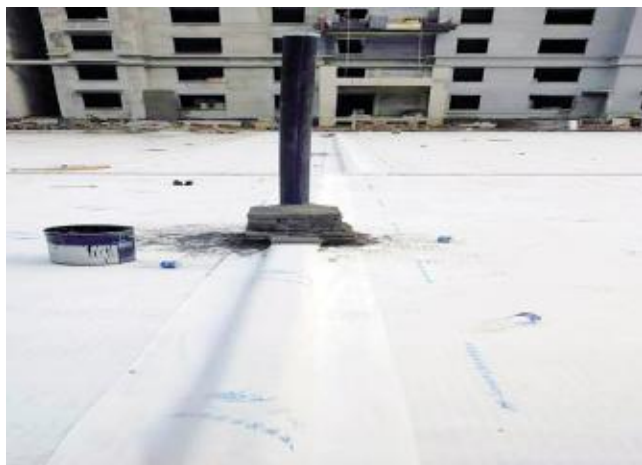
图2 虹吸排水系统施工
