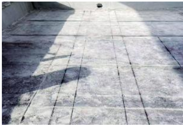
弹线错缝分隔图
