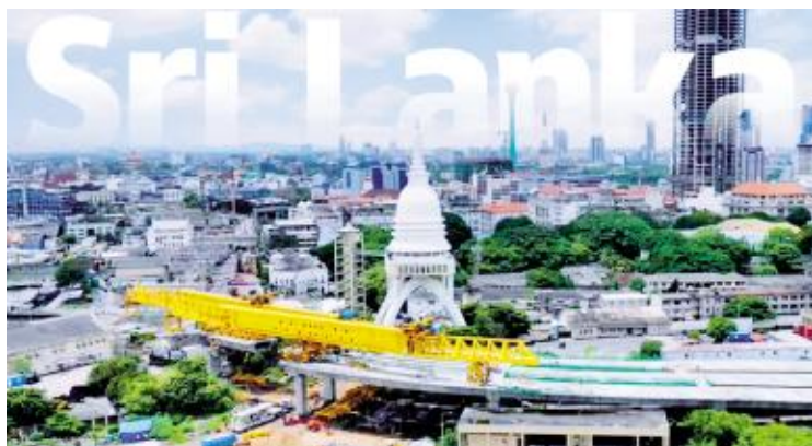
1200 吨节段拼装架桥机在斯里兰卡投入使用
