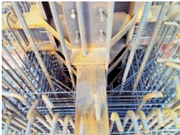
梁柱节点钢筋安装
