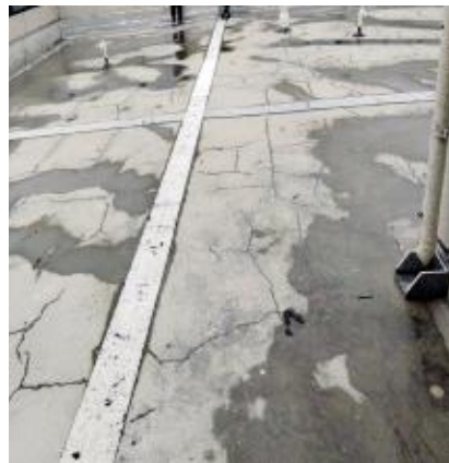
细石混凝土屋面开裂图
