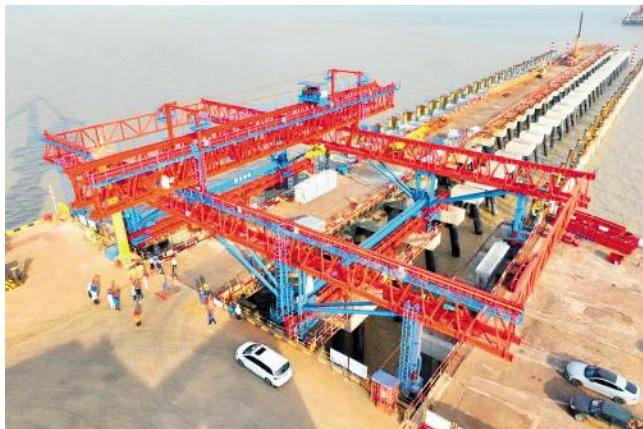
(通讯员 汪俊 何聪 曹煜)6月13日,在中交二航局承建的江苏盐城大丰港区三期通用码头3号泊位工程施工现场,位于码头墩台上方的天车正将一榀重达70吨的
