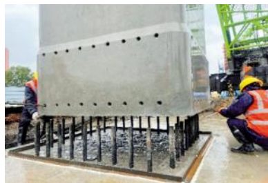
图3 G107全装配式桥梁构件架设建造现场
