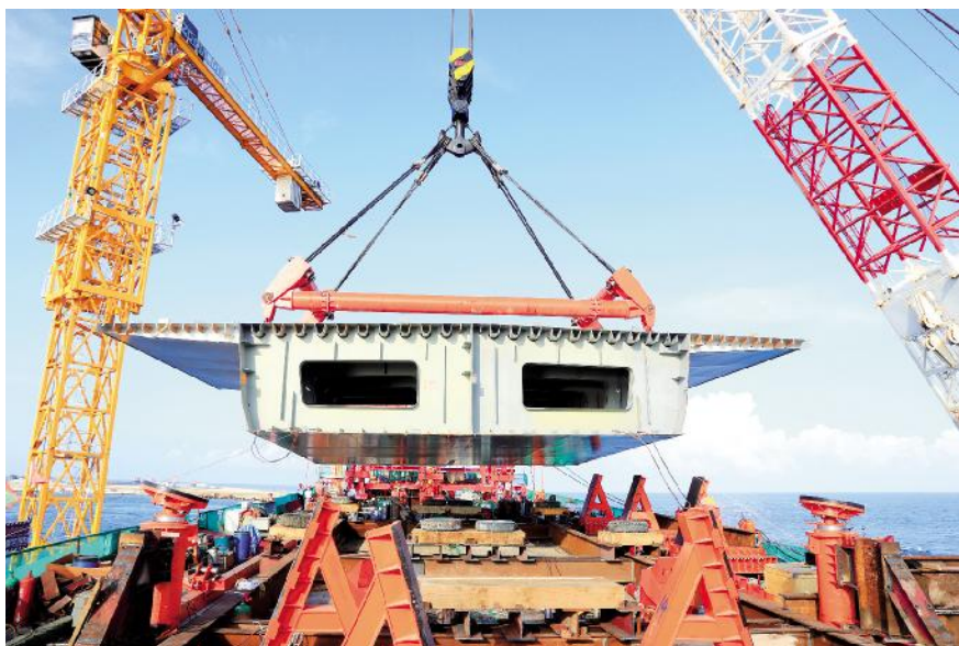
图 5 吊装中的钢箱梁
