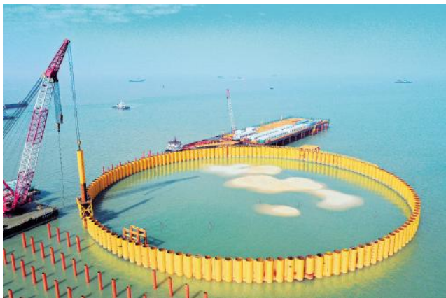
2018年11月29日,深中通道大桥东锚碇筑岛围堰成功合龙。张政 摄
