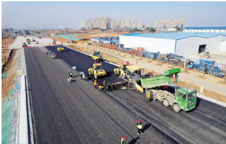
2024年3月15日,中铁十一局四公司京港澳高速(湖北孝感段)改扩建项目利用该公司智慧建造研究院研制的3D打印技术摊铺沥青施工。(谭志博摄)
