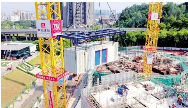
图 3 Mic 结构典型预制单元及现场安装
