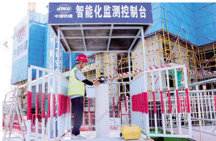
4月21日,中铁十一局河北保定城改北刘各庄安置区项目部,技术人员在调整基坑自动监测系统。(张路路摄)
