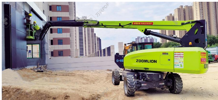
9月13日，中铁十一局保定城改北刘各庄安置区项目部，员工在工程机械上安装门卫铝包板。（田云飞摄）
