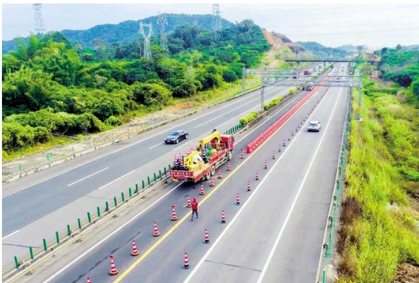
新泽西护栏围蔽施工
