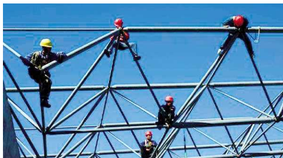
图 3.1-1 高空散装法
