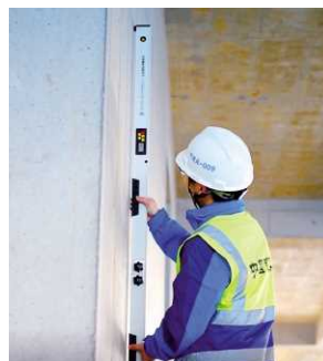
图 10 智能实测实量工具
