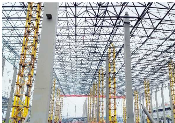
图 3.3-1 整体顶升安装法
