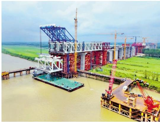
(通讯员 谢啸天 章中伟)近日,中交二航局承建的安徽池州长江公铁大桥一标项目边跨顶推区最后一节钢桁梁完成吊装,标志该项目将进入主塔区钢桁梁顶推施工阶段。
