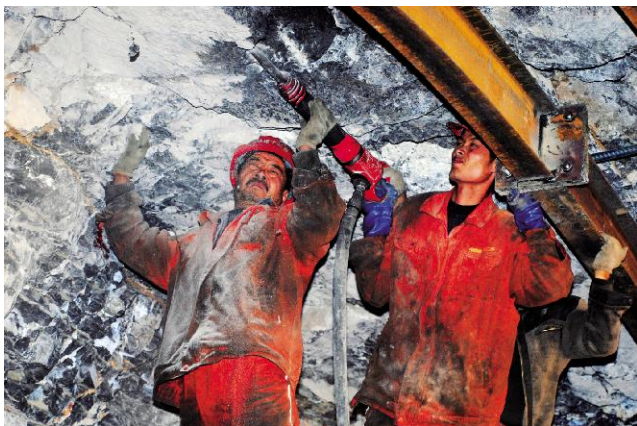
2010年3月16日、山西阳泉, 太阳高速公路大南山隧道左进口掘进班一组工人们正用风镐排除洞险石。 (本图与本文无关。安剑承摄)
