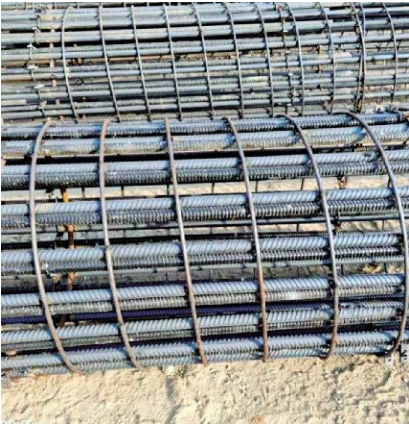
图 4.2-2 普通钢筋与玻璃纤维筋连接实景图
