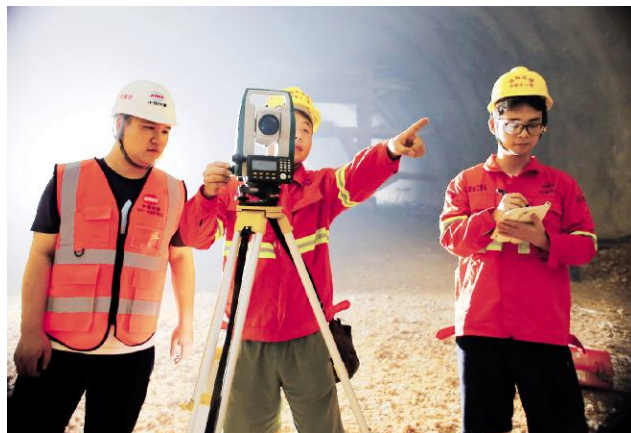
2019年5月11日,中铁十一局四公司贵南项目部防灾减灾测量小分队成员在都安隧道2号横洞复测掌子面。(郑传海摄)
