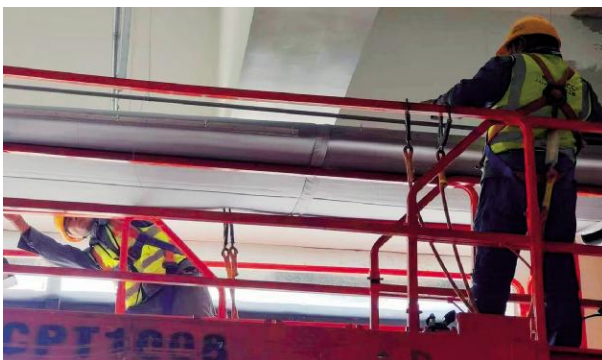
图 5.2.6-1 管段间拉链连接
