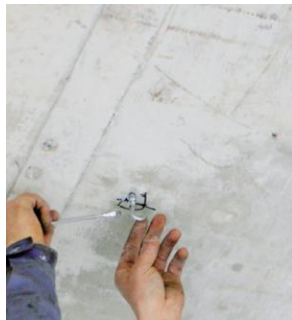
图 5.2.3-1 安装吊点
