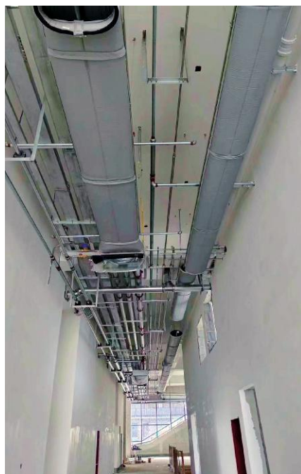
图 5.2.6-2 管段挂装完成
