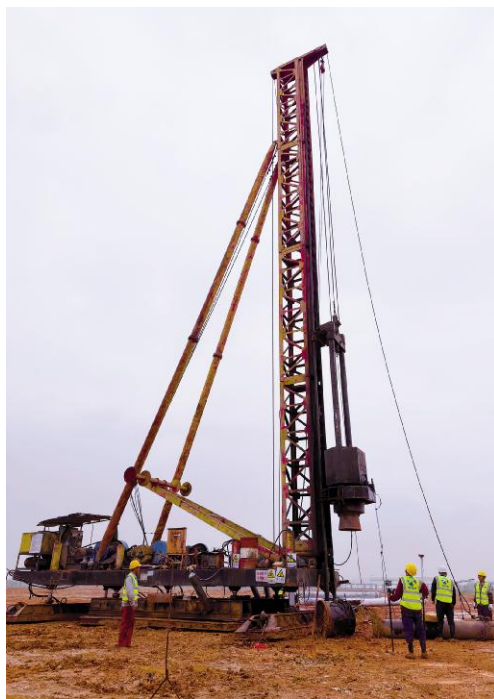
桩基施工现场安全管理
