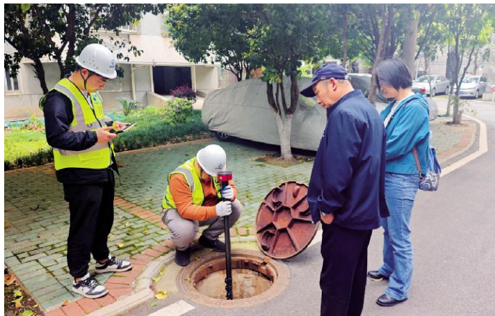
排查检测下水管道,守护城市安全
