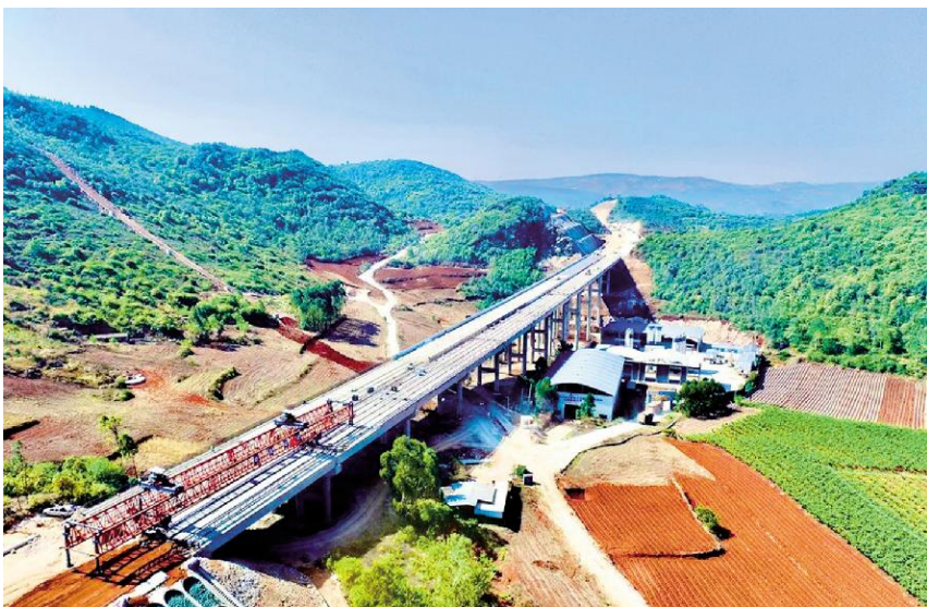
建设中的云南泸丘高速公路项目
