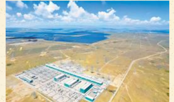
青海省海南藏族自治州共和县的±800 千伏特高压青南换流站
