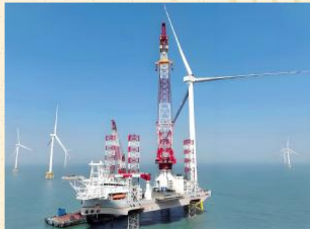
福建海域 20 兆瓦海上风电机组和“大桥海风”号 2000 吨自升式海上风电安装平台
