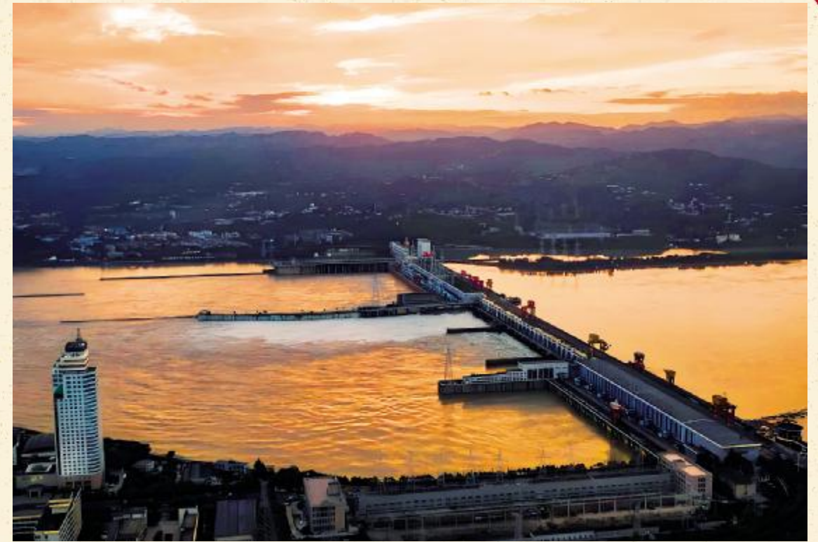
三峡水运新通道工程葛洲坝航运扩能施工现场
