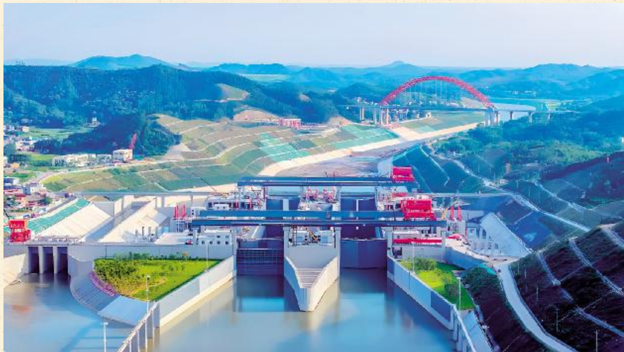
广西平陆运河马道枢纽
