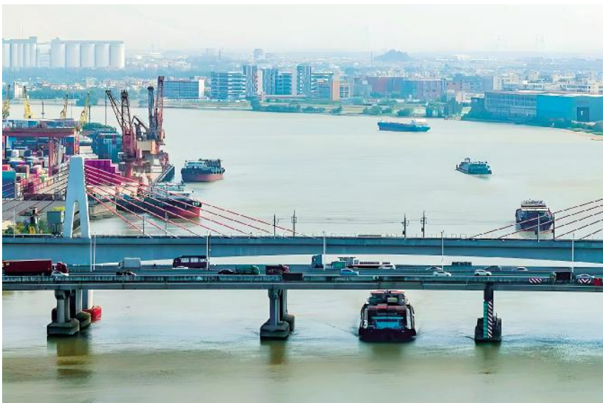
承建顺德水道航道扩能升级项目
