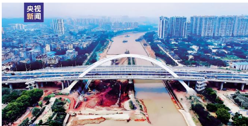
平陆运河跨河控制性桥梁永福大桥
