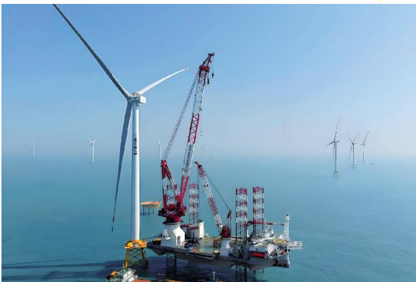
全球首台 20 兆瓦海上风电机组安装
